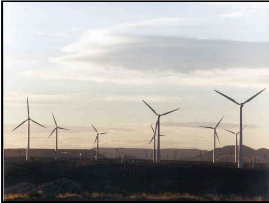
Parque eólico Antonio Morán provincia de Chubut. El mismo cuenta con 18 aerogeneradores
